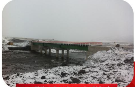
Puente El Pino- Paso Fronterizo Pichachen
