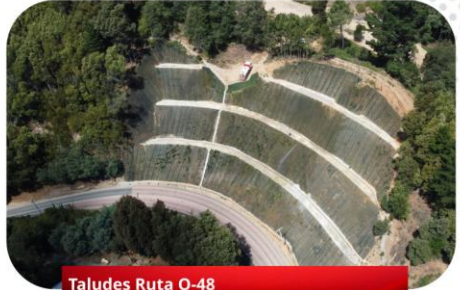
Taludes Ruta O-48
