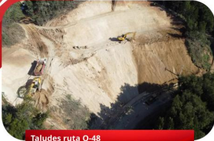
Taludes ruta O-48
