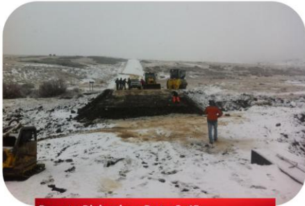
Puente Pichachen Ruta Q-45
